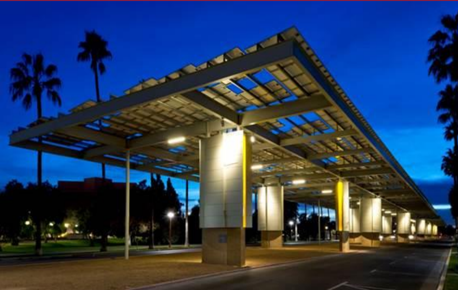
Gammage Pkwy PP, 494 kWdc PV
