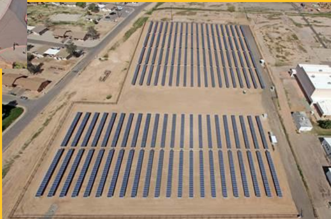
Poly Grd Mt, 801 kWdc SAT PV
